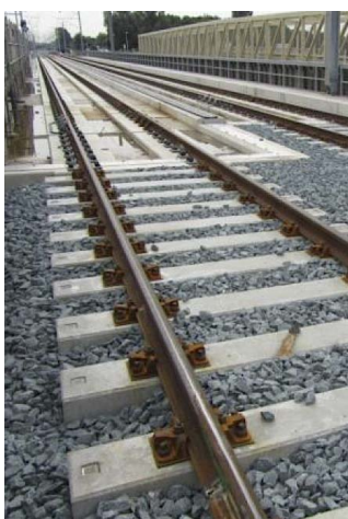
ShimLift op overgangen bij kunstwerken. Utrecht – Houten
